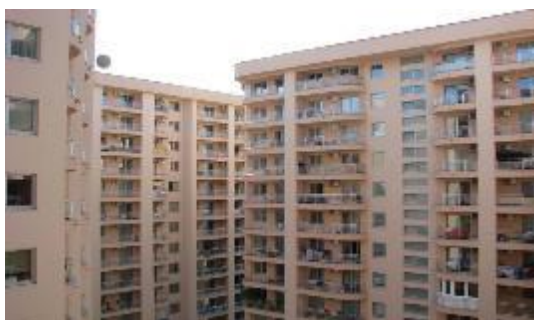
Slika 5.6 - Blokovi visokih zgrada na Stupu [51]
